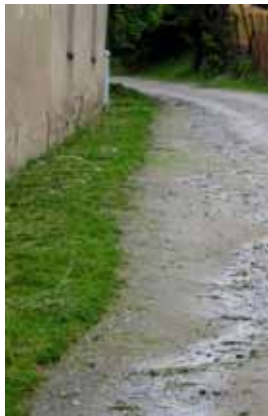
výjezd z obce (AVZO) před rekonstrukcí
